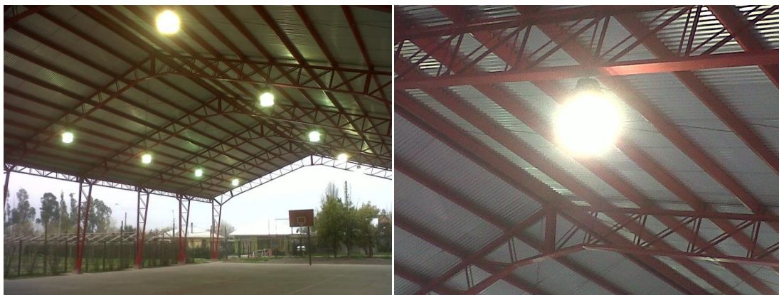
Construcción Cubierta Santa Rosa
