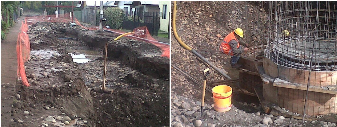
Construcción Soluciones Sanitarias y Alcantarillado de Corral de Piedras
