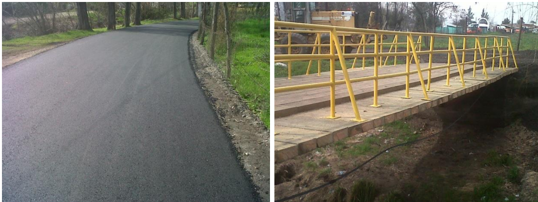
Construcción Acceso y Puente Cementerio
