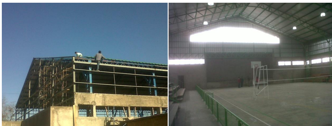
Construcción Gimnasio de Villa Prat
